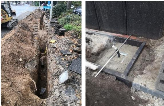
Kabeltiefbaumaßnahmen zur Stromanbindung des Anzeigers an eine Zähleranschlusssäule
