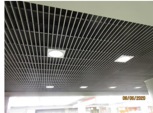
Bestandsmetalldecke mit Einbaustrahlern
