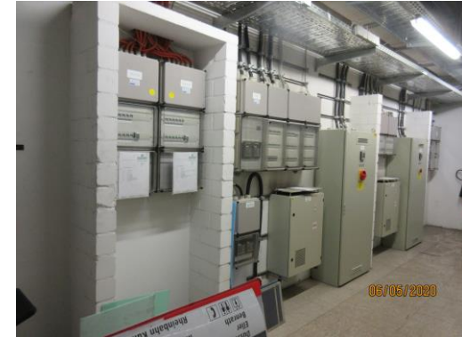
Vorhandene Unterverteiler
