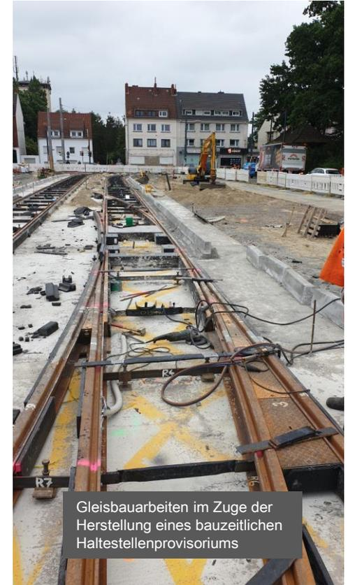
Gleisbauarbeiten im Zuge der Herstellung eines bauzeitlichen Haltestellenprovisoriums
